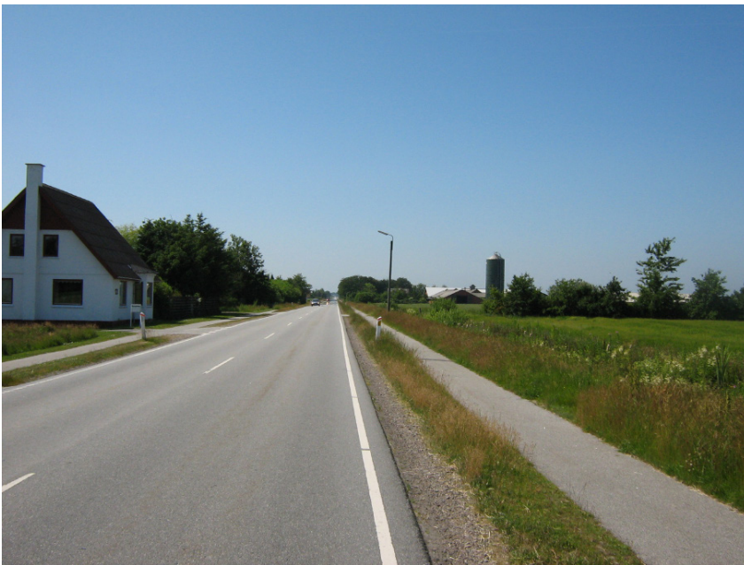
Billede 4: viser en påkørselsfarlig mast vest for Manna. Langs vejen er der få faste genstande inden for sikkerhedszonen, som bør fjernes eller flyttes.
