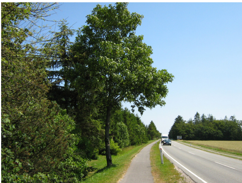
Billede 1: viser et eksempel på påkørselsfarlige træer i sikkerhedszonen (6m).
